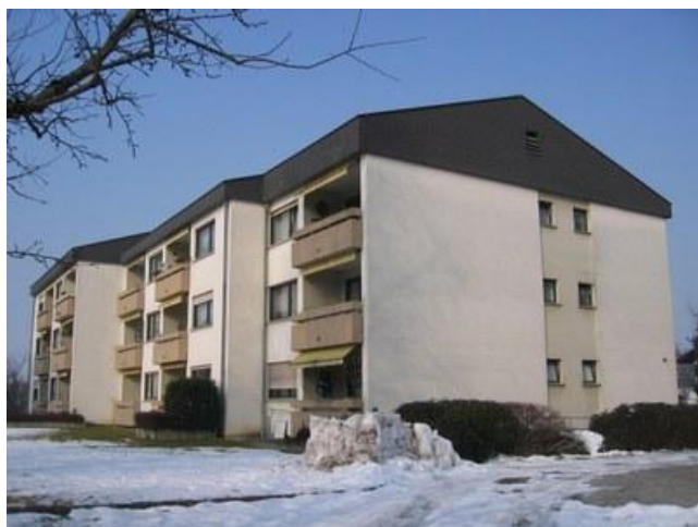
Imagen: Edificio de viviendas Rankweil-Schleipweg antes de la rehabilitación
