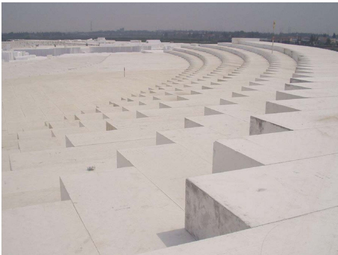
Imagen: Tribunas para el circuito de Shanghai de Fórmula 1 en construcción
