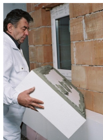
Imagen: Instalación sistema SATE
