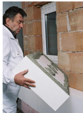
Imagen: Instalación sistema SATE
